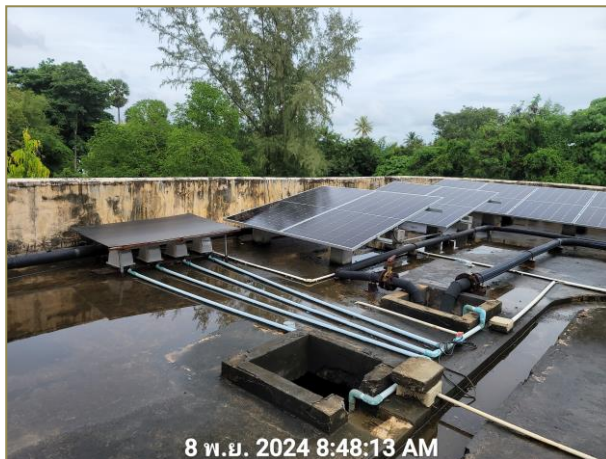
รูปที่ 2.14 บ่อพักน้ำผ่านการบำบัด + เครื่องเติมคลอรีน
