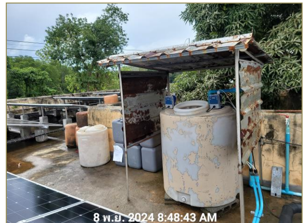
รูปที่ 2.14 บ่อพักน้ำผ่านการบำบัด + เครื่องเติมคลอรีน
