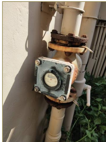
รูปที่ 2.15 มิเตอร์ระบบบำบัดแยกจากระบบไฟฟ้า
