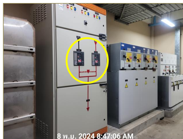
รูปที่ 2.34 circuit breaker
