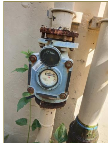
รูปที่ 2.15 มิเตอร์ระบบบำบัดแยกจากระบบไฟฟ้า
