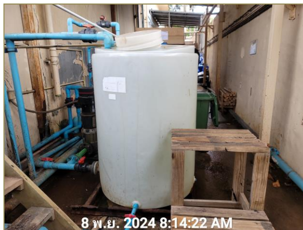
รูปที่ 2.29 ระบบกรองน้ำใช้
